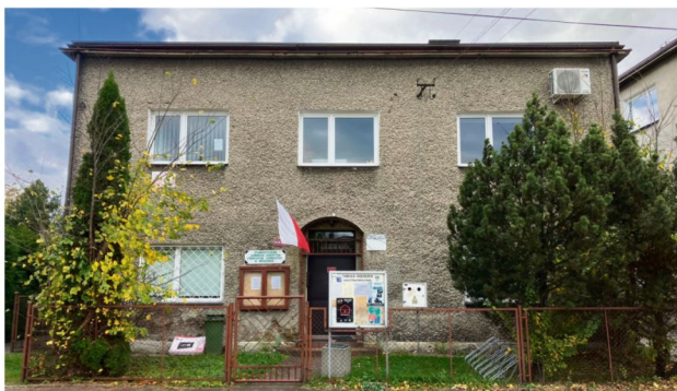
Pieniądze z funduszu sołeckiego Brzezinki na 2024 rok zostaną przeznaczone m.in. na pierwszy etap modernizacji gminnego budynku przy ulicy Czernichowskiej 4. Fot. mc
