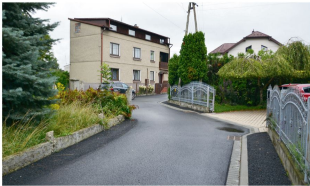
Remont ulicy Zamkniętej w Babicach został sfinansowany z funduszu sołeckiego na lata 2022 i 2023. Fot. mc
